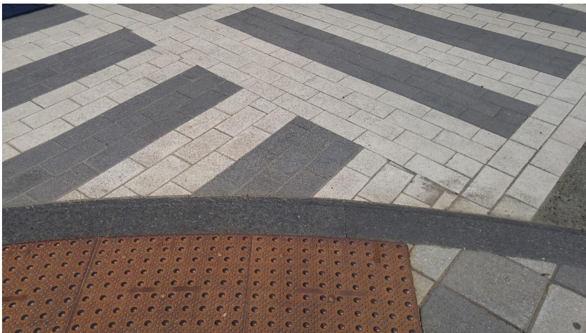
Photo : Passage piétonnier aménagé avec la dalle podotactile
