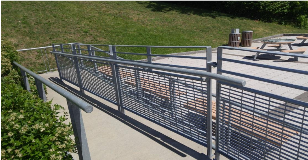
Rampe d'accès sur le quai
